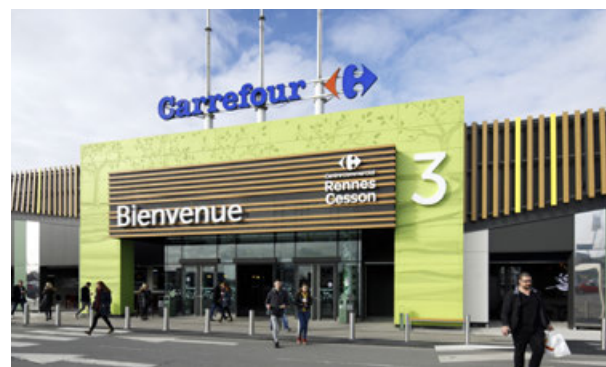
Le centre de Rennes Cesson, après l'inauguration d'une extension en 2019, a reçu la certification BREEAM New Construction en octobre 2020.
