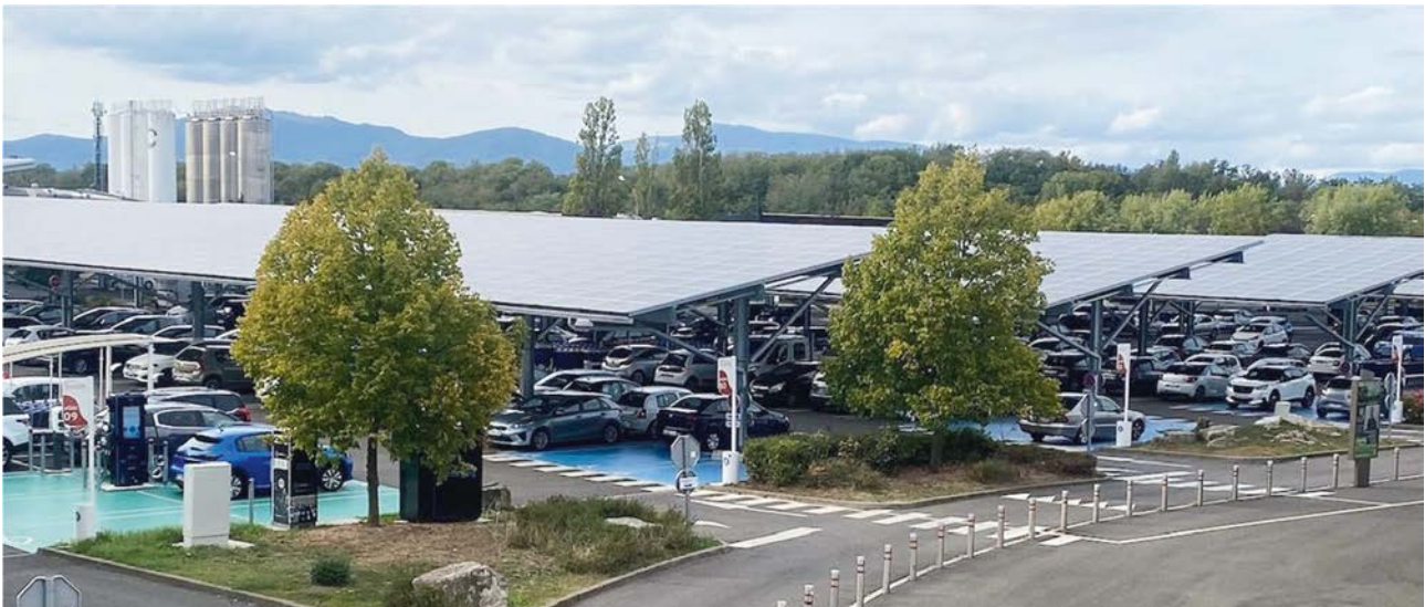
Shop'in Witty (Wittenheim) – Finalisation de l'installation des ombrières en 2022
